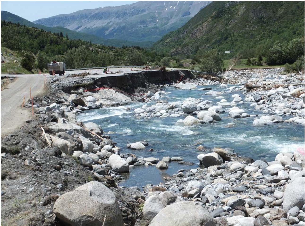
Figura 2: La avenida del río Ésera en junio de 2014 alteró profundamente el cauce fluvial y destruyó tramos de carretera, reflejando la ocurrencia de eventos hidrológicos con elevado riesgo para la población e infraestructuras. El arrastre de grandes bloques, la mayor parte de origen morrénico, es un buen indicador de la capacidad de erosión y transporte de los ríos pirenaicos, caracterizados por avenidas súbitas y fuertes pendientes. Foto: J.M.G.R.
